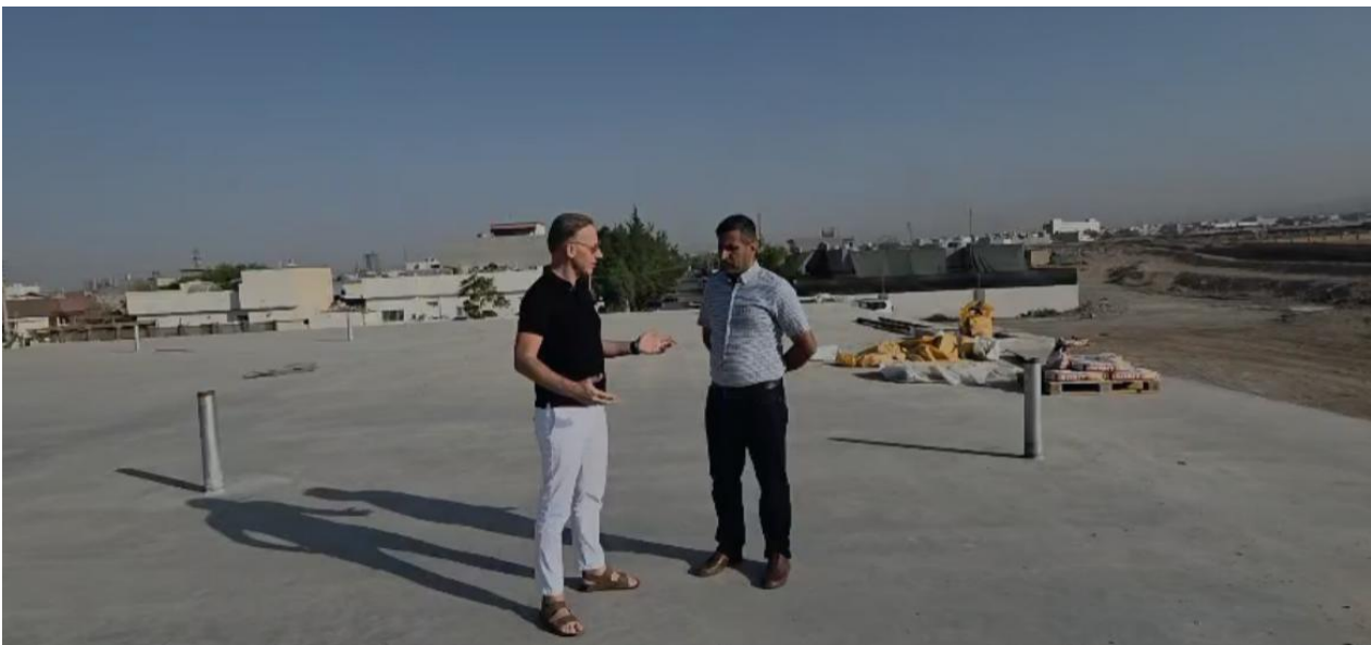
Vor-Ort-Austausch in Erbil zur mineralischen Sicherung neu errichteter Wasserbehälter und Bauwerksflächen. Bildquelle: interne ÖBI-Dokumentation.
