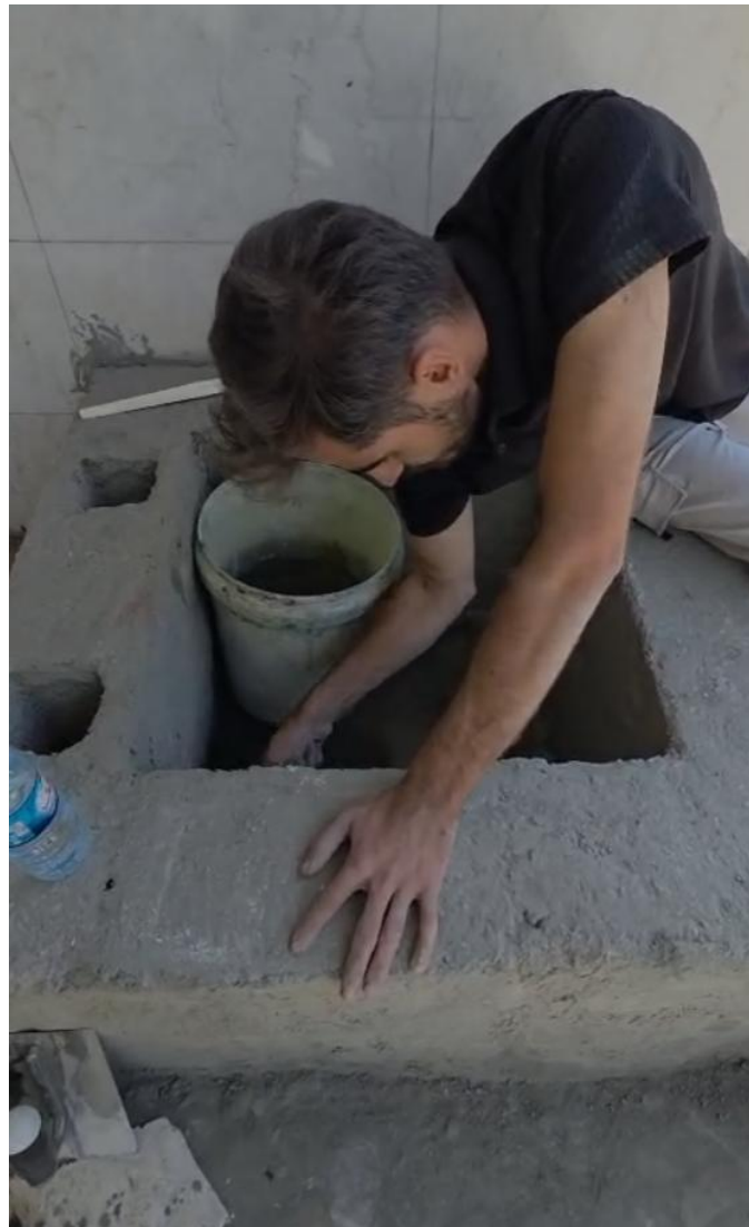
Praxisnahe Schulung zur Abdichtung und mineralischen Sicherung eines Betonbauteils. Bildquelle: interne ÖBI-Dokumentation.
