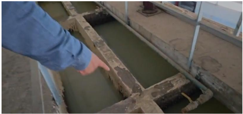
Dokumentation stark geschädigter Wasserbehälter in Erbil vor der Instandsetzung. Salzbelastung und Materialschäden beeinträchtigen die langfristige Nutzung und Wasserhygiene. Bildquelle: interne ÖBI-Dokumentation.
