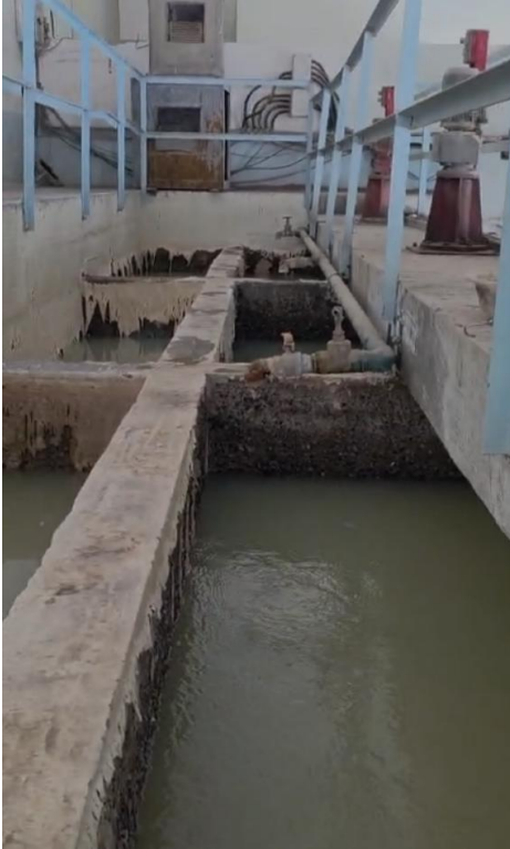
Dokumentation stark geschädigter Wasserbehälter in Erbil vor der Instandsetzung. Salzbelastung und Materialschäden beeinträchtigen die langfristige Nutzung und Wasserhygiene. Bildquelle: interne ÖBI-Dokumentation.
